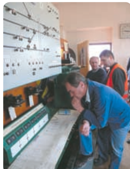
Zamestnanci správcu i údržby spoločne kontrolujú správnosť zapojenia elektrického obvodu na stavadlovom prístroji.
