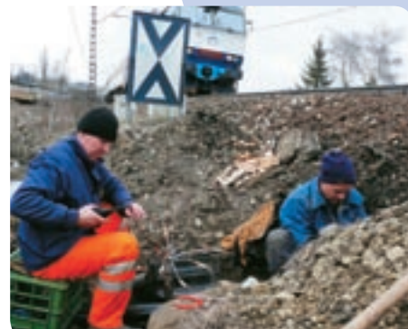
Spoj Boženu s Cyrilom...znamená spojiť „b“ s „c“, pri tejto práci sme zastihli majstra kábelovej techniky Jána Plačka (vpravo) a oznamovacieho návěstného obvodára Petra Šoltýsa z SMÚ OZT KT Spišská Nová Ves
