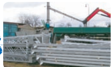
V areáli stanice Kuzmice sa zhromažďujú trakčné podpery.
