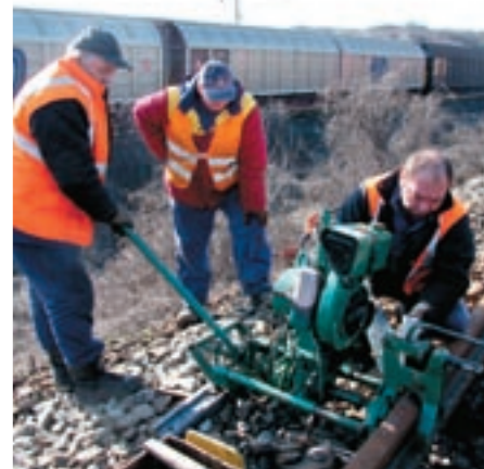
Traťoví robotníci Ján Kerekanič, Štefan Hertel a zámočník Marián Šimko pri vŕtaní koncových dier do zabudovanej novej koľajníc.
