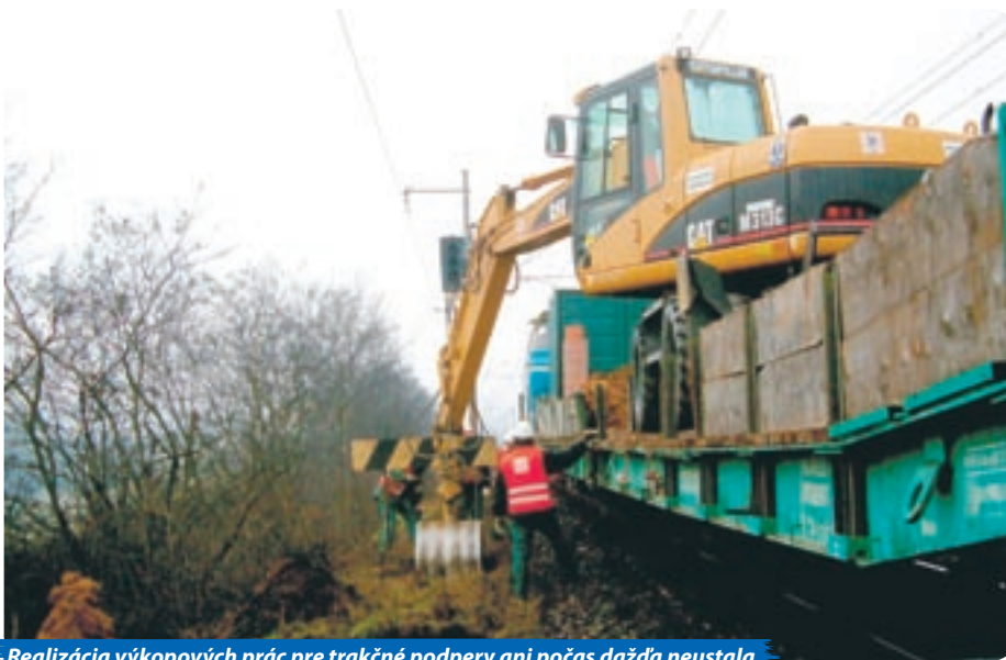
Realizácia výkopových prác pre trakčné podpery ani počas dažďa neustala.
