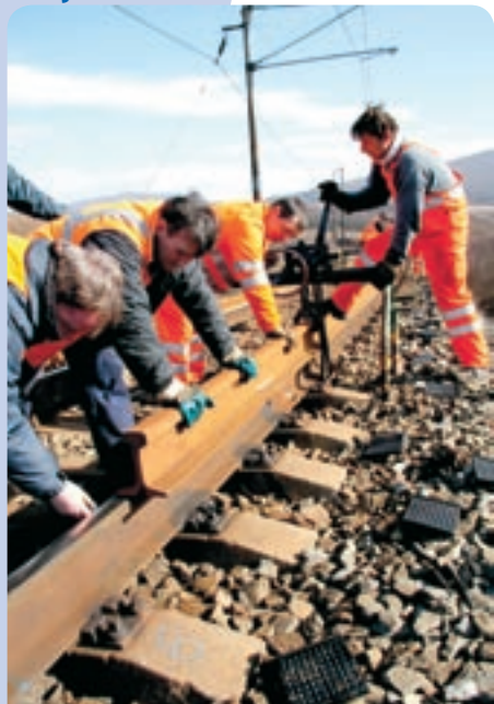
Majster Lubomír Hertel za pomoci zámočníka Mariána Hertela a traťových robotníkov Róberta Bertu a Vladimíra Sedláčka pri presnom označení koncového rezu koľajníc v oblúku.
