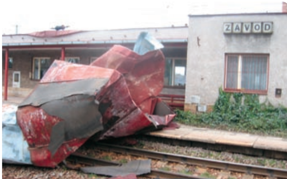
Uragán Emma v celom priestore Záhoria demoloval to, čo sa mu dostalo do cesty, na zastávka Závod nápor vetra nevydržala strecha.
