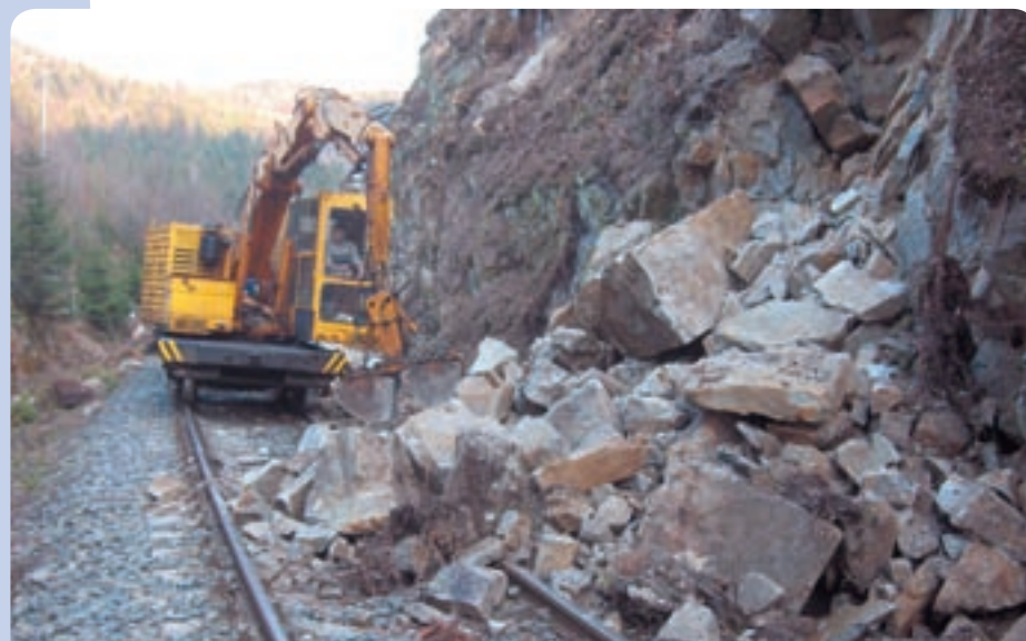
Opakované zosuvy skál nie sú ničím výnimočným v hnileckej doline. Trať je aj v súčasnosti prístupná v nebezpečnom úseku iba pre pomalú jazdu.
