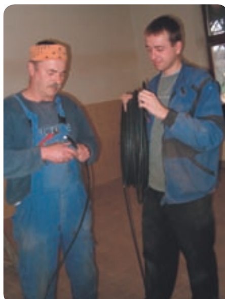
Elektrikári z firmy Tensor, s.r.o., z Martina si pripravujú elektroinštalačný materiál pre montáž stropného osvetlenia, zároveň pracujú aj na sprevádzkovaní signalizácie a dátovej siete.
