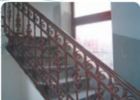
Schodište s klasickým zábradlím zostáva zachované a v pôvodnom stave.
