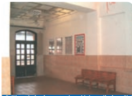
Prijímacia budova stanice aj jej vestibul prešiel úpravami a pribudli aj tri nové vchodové dvere.
