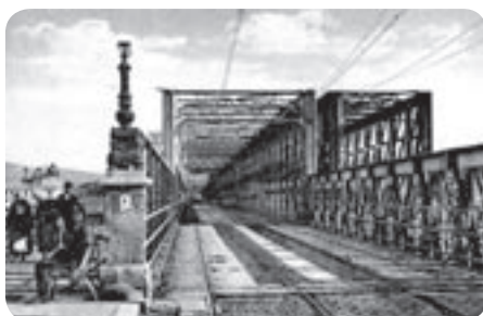
Zaujímavosťou mosta cez Ipel' je, že tento pomerne neobvyklý most pre lokálku je vlastne jedným z polí pôvodného bratislavského mosta Františka Jozefa cez Dunaj z roku 1891. Na archívnej fotografii MDC je železničný most v pravo, kolajnica na širšom cestnom ľavom moste patria električke Bratislava – Viedeň.
