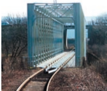
Zaujímavosťou mosta cez Ipel' je, že tento pomerne neobvyklý most pre lokálku je vlastne jedným z polí pôvodného bratislavského mosta Františka Jozefa cez Dunaj z roku 1891. Na archívnej fotografii MDC je železničný most v pravo, kolajnica na širšom cestnom ľavom moste patria električke Bratislava – Viedeň.
