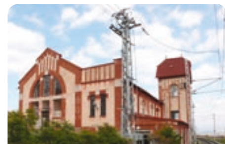
Trakčná meniareň v Starom Smokovci, postavená v roku 1911 počas budovania trate Tatranská Lomnica - Štrbské Pleso.
