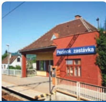
Zrekonštruovalo sa päť železničných staníc, jedna výhybňa a jedna zastávka.
