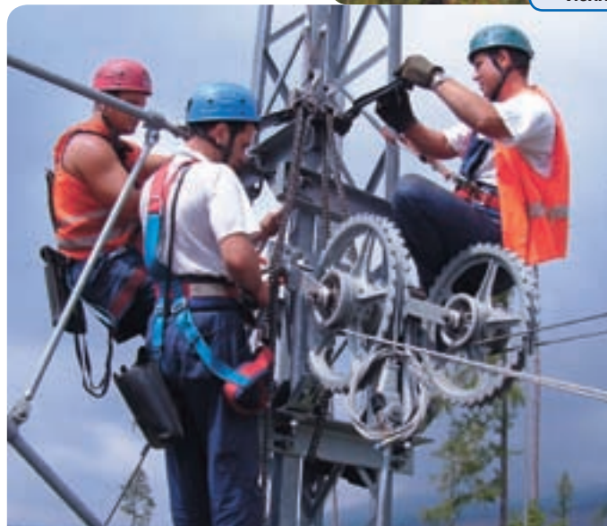
Kalamita preverila hlavne zamestnancov údržby, ktorí na oprave trakčného vedenia mali plné ruky práce.
