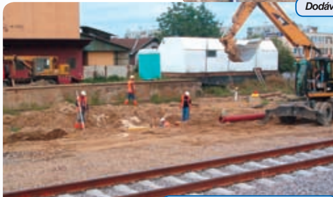
...a pripravujú odvodnenie pre budúce koľaje.
