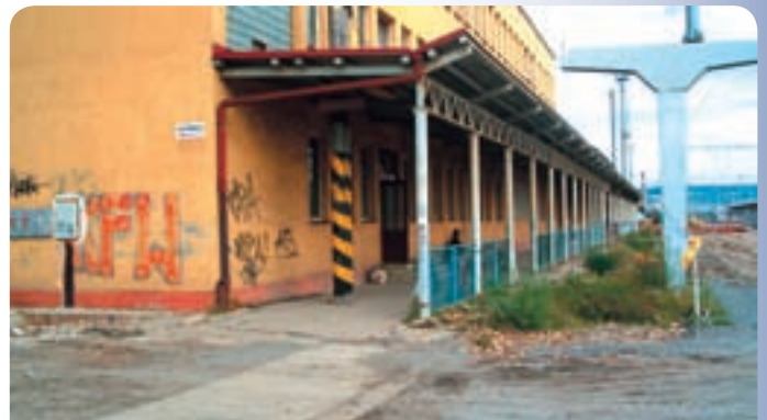
Stará dlažba na nástupišti sa v najbližších dňoch rozeberie, aby mohli byť uložené kábelovody.
