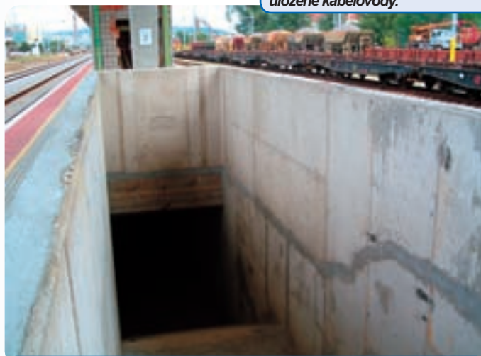
Pochod je už stavebne pripravený a čaká na konečné úpravy...
