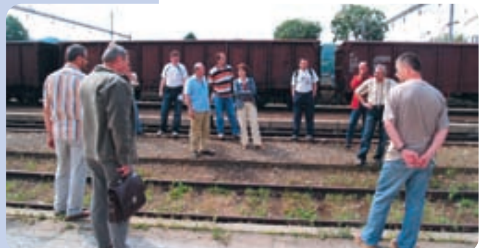
Na zvolenskej nákladnej stanici po rokoch obnovujú štvrtú koľaj. Na pracovnej porade sa k tomu zišla i odborná komisia, kde nemohol chýbať ani koordinátor SMS.
