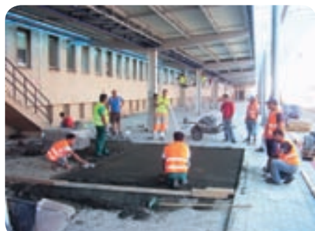
S nasadením stavebných dodávateľov sa mení i dlažba perónu.
