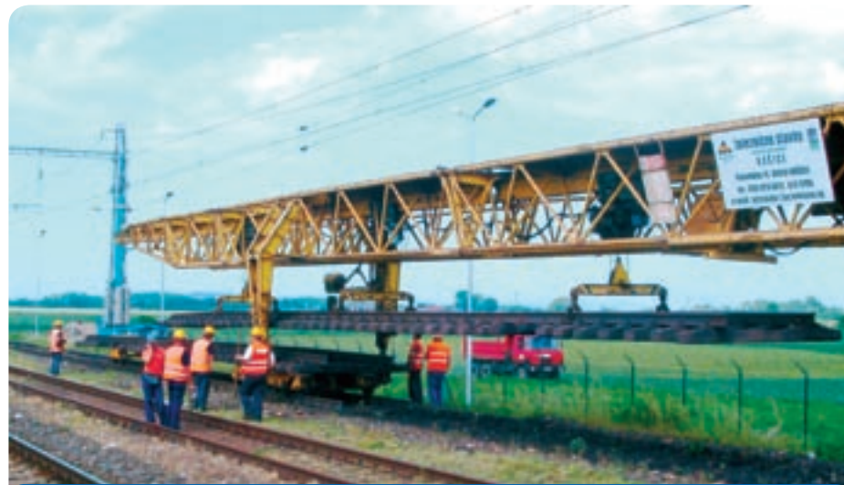
Železničné stavby, a.s. Košice, ako hlavný dodávateľ, premiestňujú starú koľaj v priestore štátnej hranice UŽ a ŽSR.
