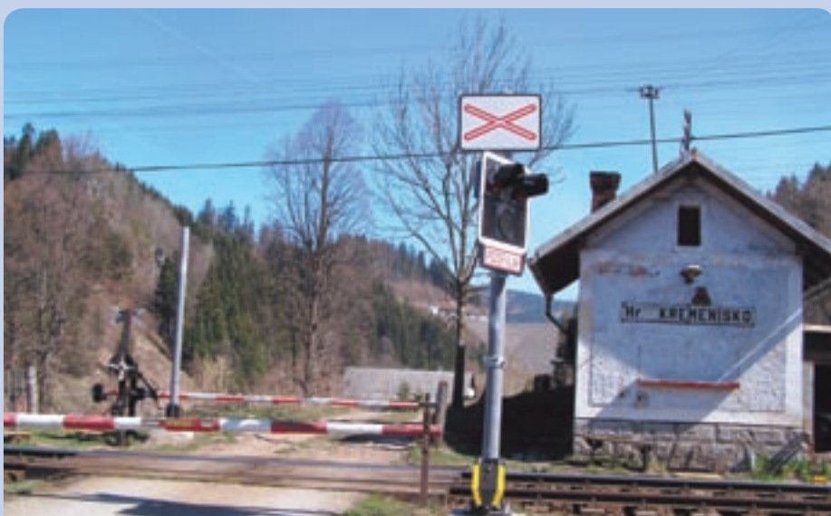
Na hradle Kremenisko už slúži nové priecestné zabezpečovacie zariadenie, ktoré bez pochyb prispieje k väčšej bezpečnosti.
