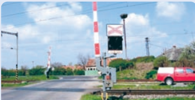
Poškodené železničné priescestie na úseku Podhájska – Lok vďaka pohotovému zásahu našich kolegov už opäť slúži svojmu účelu.
