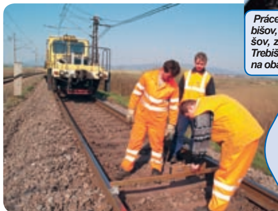
Na traťovom úseku medzi Výhybňami Červený dvor a Trebišovom sme zachytili pri práci traťovákovo zo širokého rozchodu SMÚ TO Trebišov. S mechanizmami im vypomáhali zamestnanci z MDS Trebišov, Miroslav Čížmár a Jozef Krasnič, ktorých na zábere vidíme s majstrom traťovákovo Slavomírom Kollárom pri meraní koľaje.
