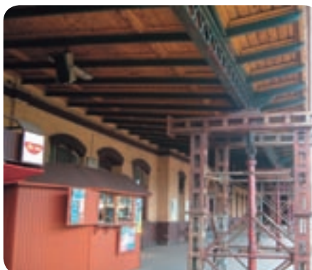
Narušenú statiku prístreška na prvom nástupišti bolo nevyhnutné riešiť podoprením.
