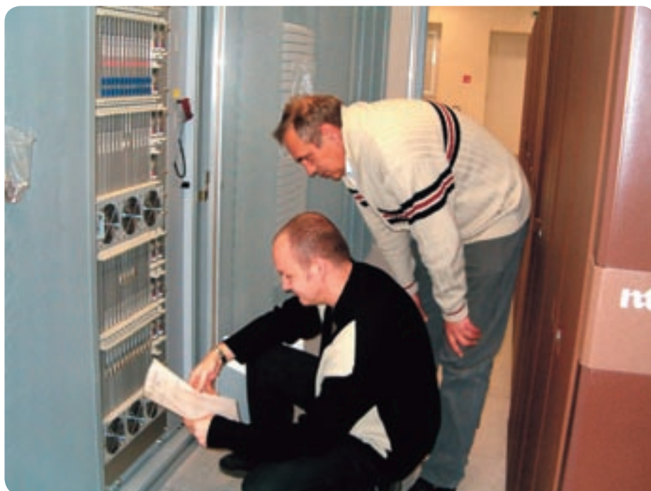
V ústredni priestrannej budovy, ktorá prešla rekonštrukciou sme stretli operátorov Romana Šmida (v pokľaku) a Dušana Miklu.
