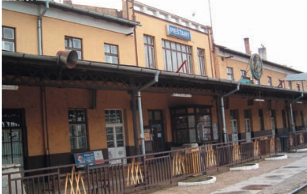
Budova železničnej stanice v Piešťanoch výrazne zmení svoj vzhľad hlavne vo vnútorných priestoroch.
