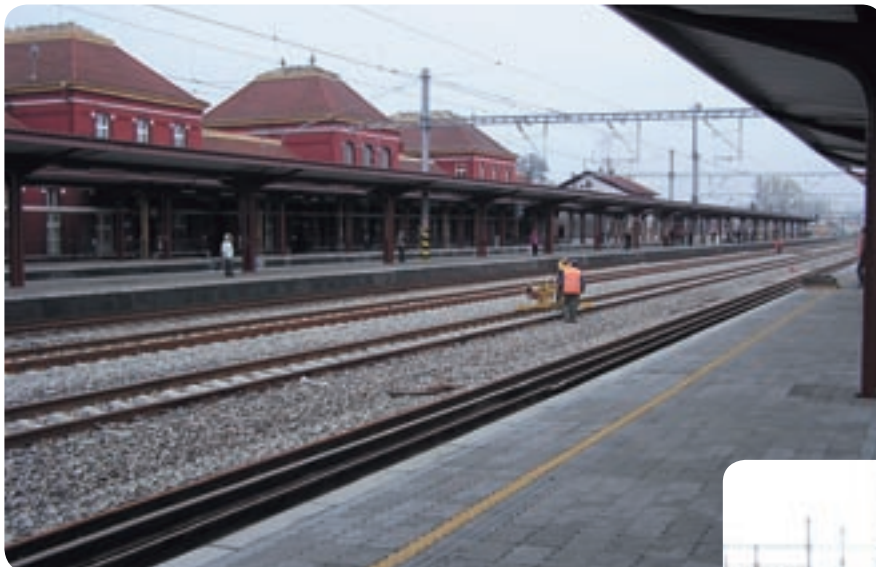
Pohľad na železničnú stanicu v Leopoldove z tretieho nástupištia na sklonku roku 2006.
