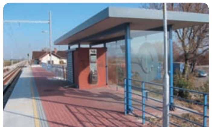
Zastávka Madunice po rekonštrukcii. Na trati medzi Veľkými Kostoľanmi a Leopoldovom.
