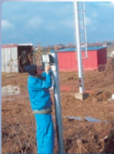
Zástupca zahraničnej firmy na stožiare umiestňuje technologické zariadenie na kontrolu vozňov.
