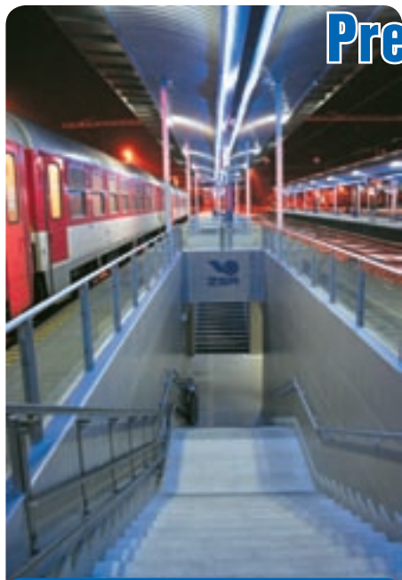
Nové podchody sú dôležité pre bezpečnosť cestujúcich.
