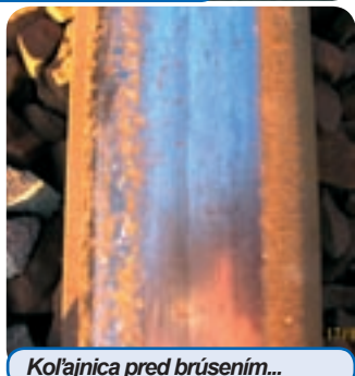
Koľajnica pred brúsením...
