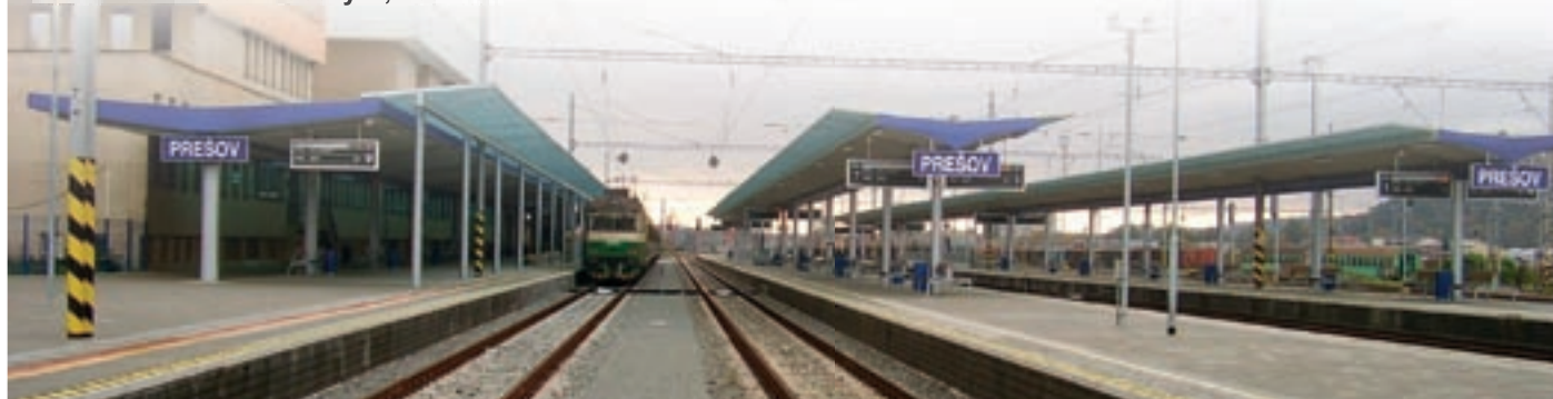
Celkovo boli vybudované v Prešove tri nástupišťa so zastrešením, z toho dve úplne nové a jedno (prvé nástupište) bolo kompletne zrekonštruované. Plocha nástupišť medzi hranami je vyplnená zámkovou dlažbou.
