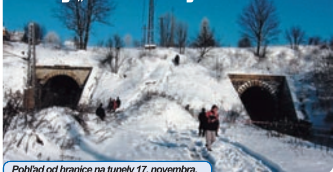
Pohľad od hranice na tunely 17. novembra.
