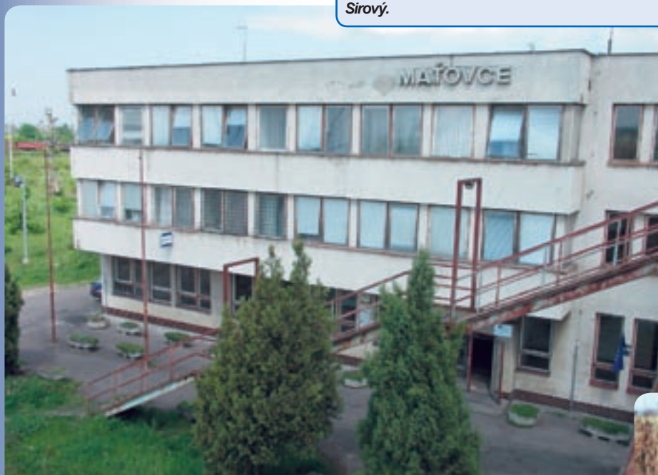
Staničná budova slúži od roku 1984. Už od začiatku je považovaná za stavebný „nedorobok“.
