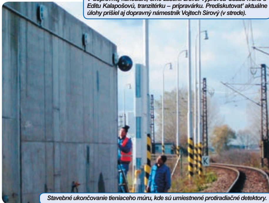
Zástupca zahraničnej firmy na stožiare umiestňuje technologické zariadenie na kontrolu vozňov.
