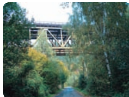
Ružínsky viadukt, alebo aspoň časť z neho, slúži od roku 1955 a vtedy ho stavali Hutní montáže Ostrava a Oceľové stavby Brno.
