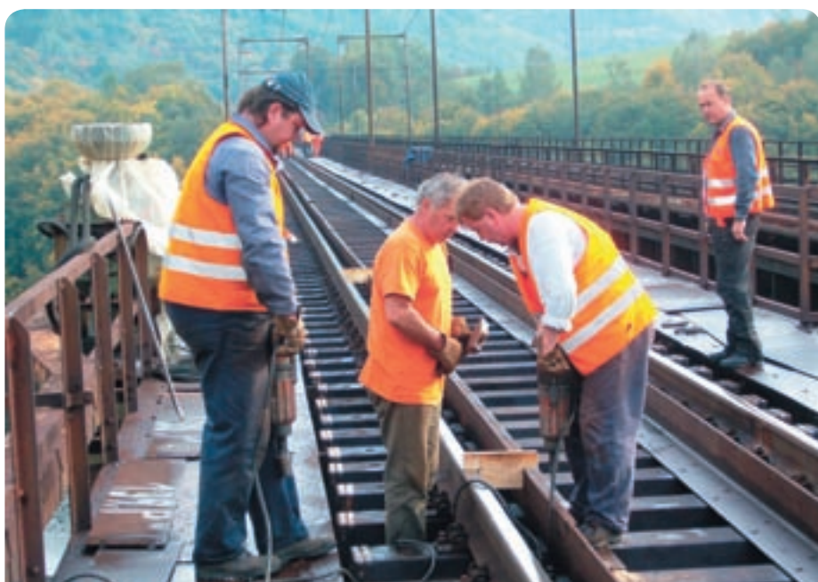
Do nastavovania polohy poistných uholníkov sa vrtajú otvory a pripevňujú tzv. vrtulami. Túto prácu práve vykonáva Jaroslav Kurta a Ondrej Matis. Vľavo Ondrej Šofranko. Počínaniu kolegov sa prizerá aj majster Ján Jakubišín (vpravo).
