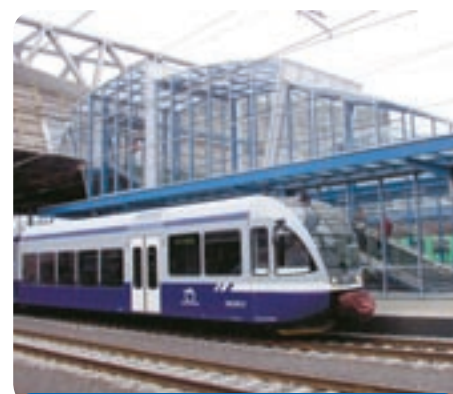
Počas rekonštrukcie sa vybudovali presklené nadchody zabezpečujúce mimoúrovňový prístup k nástupištiam električiek TEŽ.
