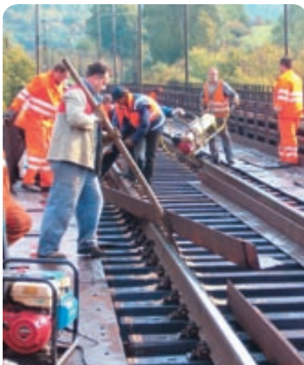
Montáž poistného uholníka a jeho ukladanie si vyžaduje nacvičené úkony i fyzickú zdatnosť, veď ide o 12 metrovú dĺžku a 650 kilogramovú váhu.
