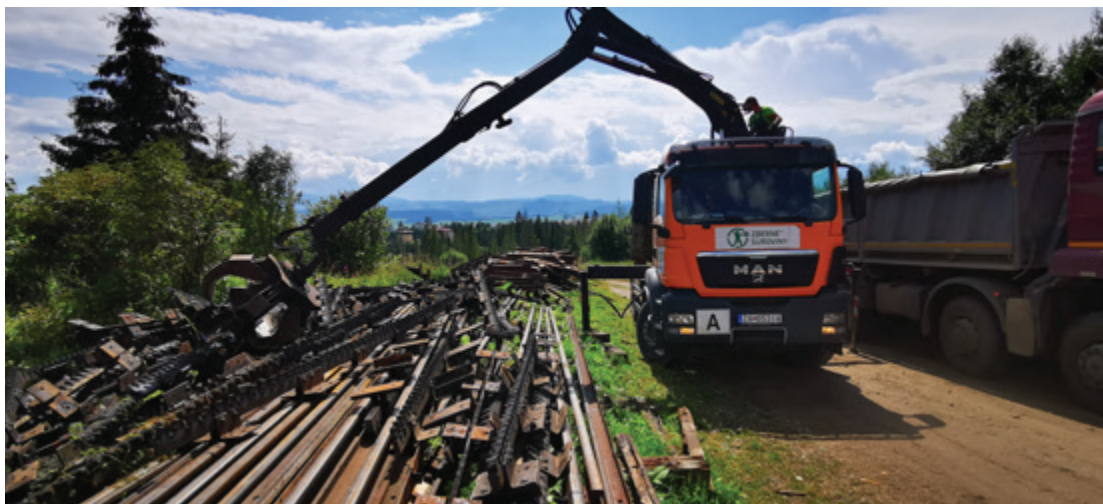
Likvidácia zvrškového materiálu.
