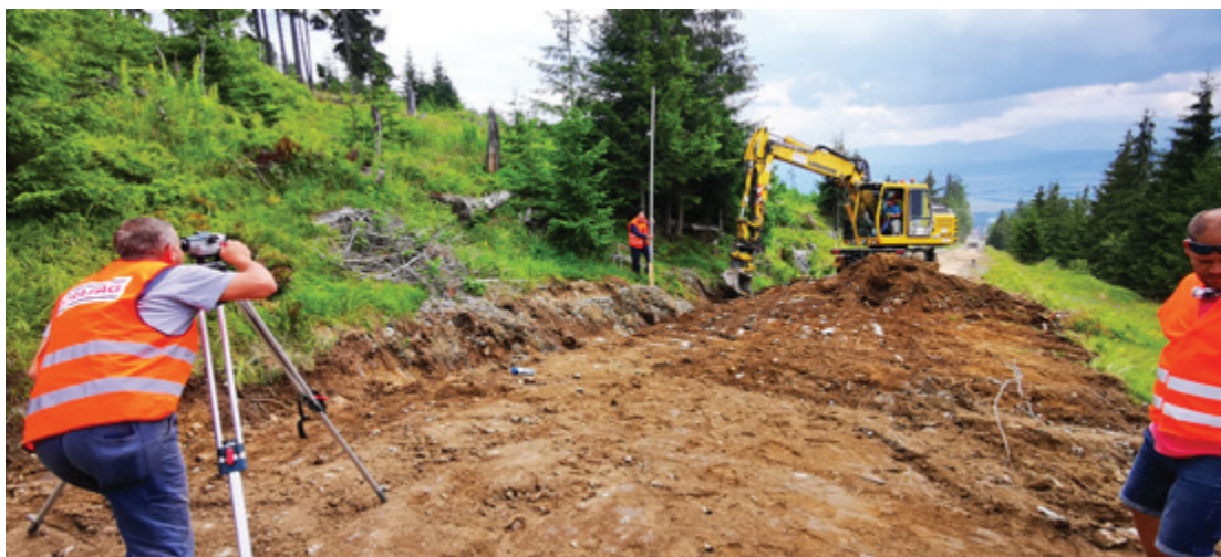
Kontrola výšky pláne železničného spodku.
