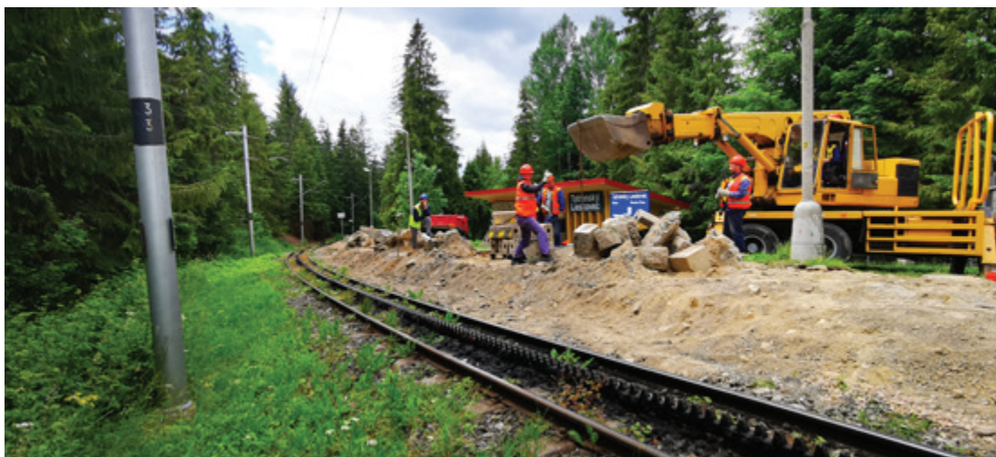
Demontáž nástupištia Tatranský Lieskovec.
