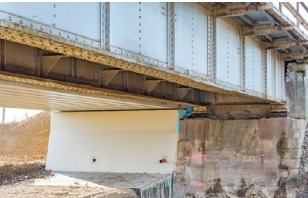
Vľavo nová železobetónová a vpravo stará oceľová konštrukcia.
