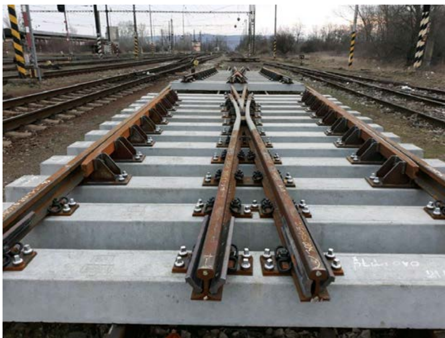
Príprava výhybiek 17A a č. 21A pred kladením.
