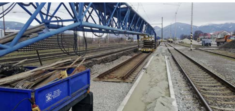
Prebiehajúce rekonštrukčné práce v ŽST Martin.
