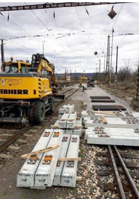
Úprava koľajového lôžka pred kladením prípojných polí a výhybiek.
