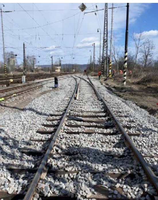
Výhybky č.17A a 21A po smerovej a výškovej úprave.
