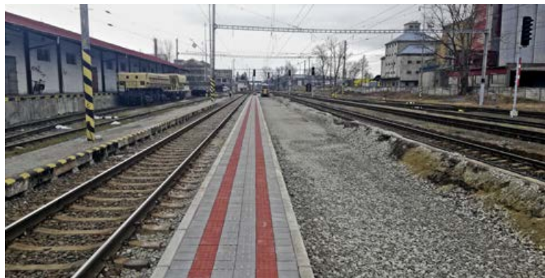
Prebiehajúce rekonštrukčné práce v ŽST Martin.
