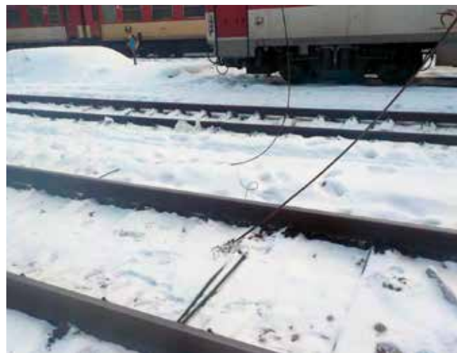
Poškodené trakčné vedenie, previs trakčného vedenia, prepálený trolejový drôt a kotvový nástavec.
