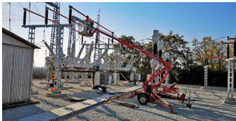
Realizácia rekonštrukcie rozvodne 110kV v TNS Galanta.
