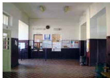
Takto vyzeral vestibul pred opravami.
