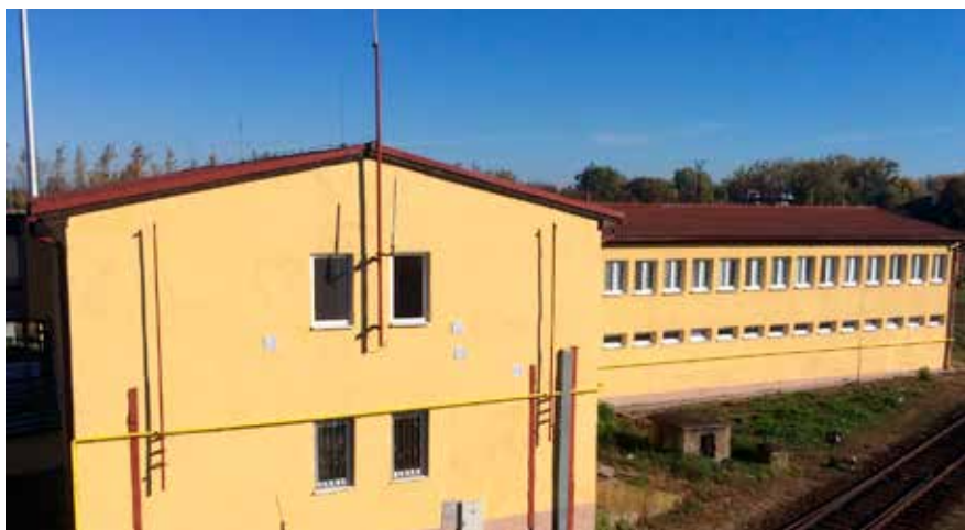
Takto dnes vyzerá komerčná budova na krytej rampe v Čiernej nad Tisou po oprave.
