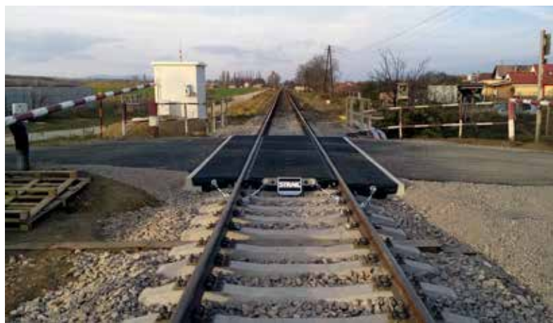
Vyasfaltované priecestie s novoosadenou priecestnou konštrukciou.
