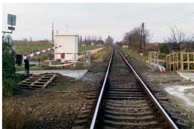
Práce na rekonštrukcii priecestia v plnom prúde.
