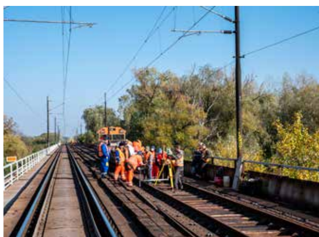
Kontrola rozchodu koľaje, vytýčenie a kontrola geometrickej polohy koľaje.
