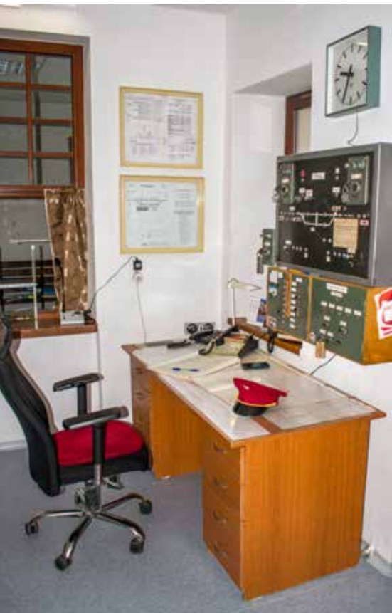
Lepšie sociálne zázemie pre prácu výpravcu.
