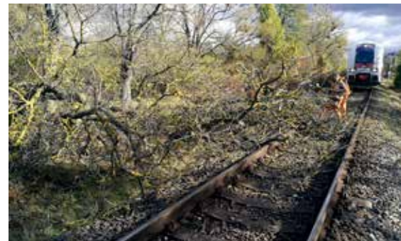
Odstraňovanie spadnutého stromu v úseku Kamenica nad Cirochou – Humenné.
