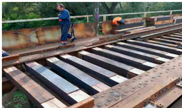
Mostnice uložené a pripravené na doopracovanie. Značenie a frézovanie otvorov na nity a vrtanie otvorov na mostnicové skrutky v koľaji č. 1.
