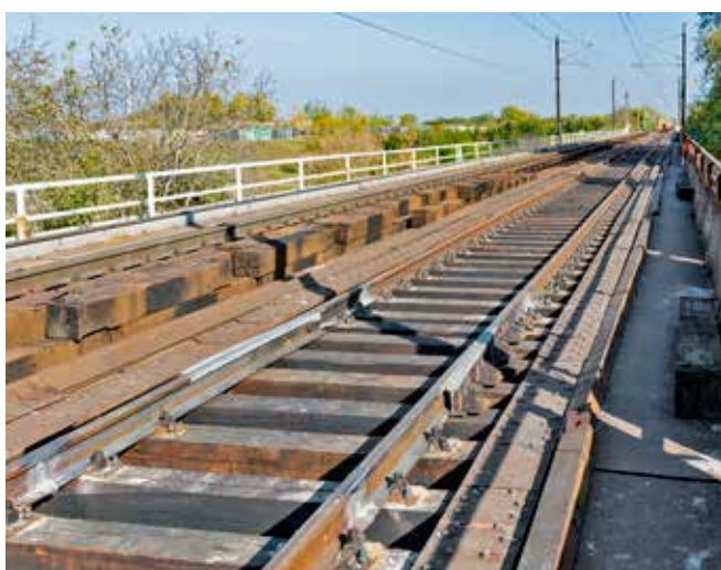
Dilatačné zariadenie v strede mosta slúžiace na korekciu dĺžkovej rozťažnosti koľajnic pri zmene teplôt.
