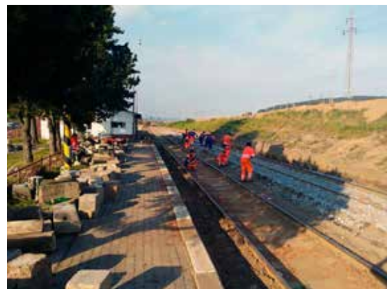
Zamestnanci SMSÚ ŽTS TO SNV pri dopĺňaní štrkového lôžka koľaje č. 1 pred OGPK.
