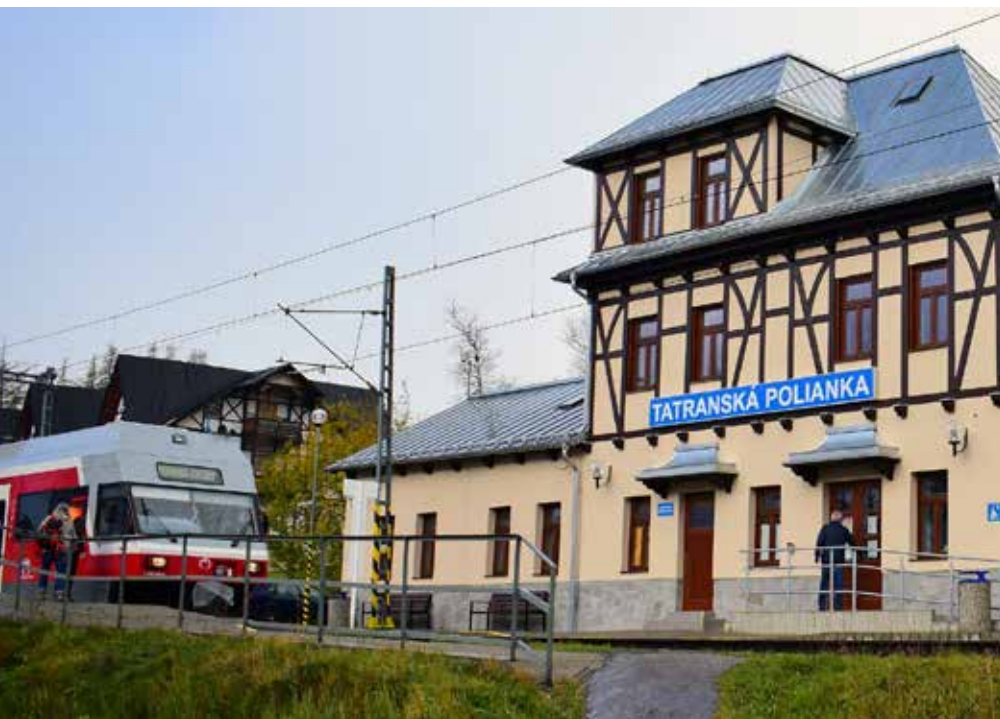
Novozrekonštruovaná zastávka Tatranská Polianka
