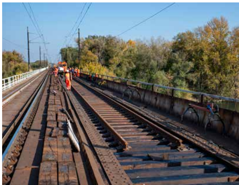
Zriadenie železničného zvršku na novovymenených mostniciach – pokládka koľajnicových pásov.
