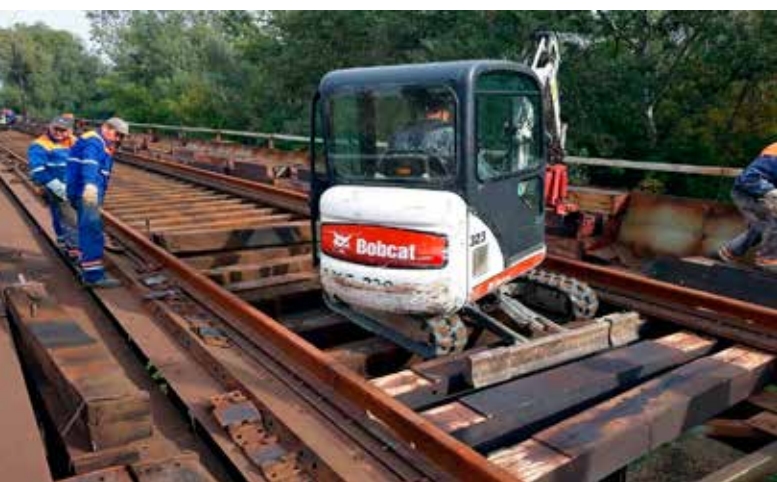
Výmena starých mostníc za nové pomocou stroja koľaje č. 1.
