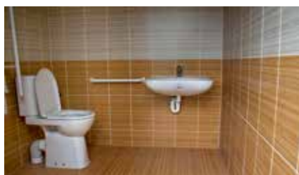
Zriadenie WC pre imobilných cestujúcich.
