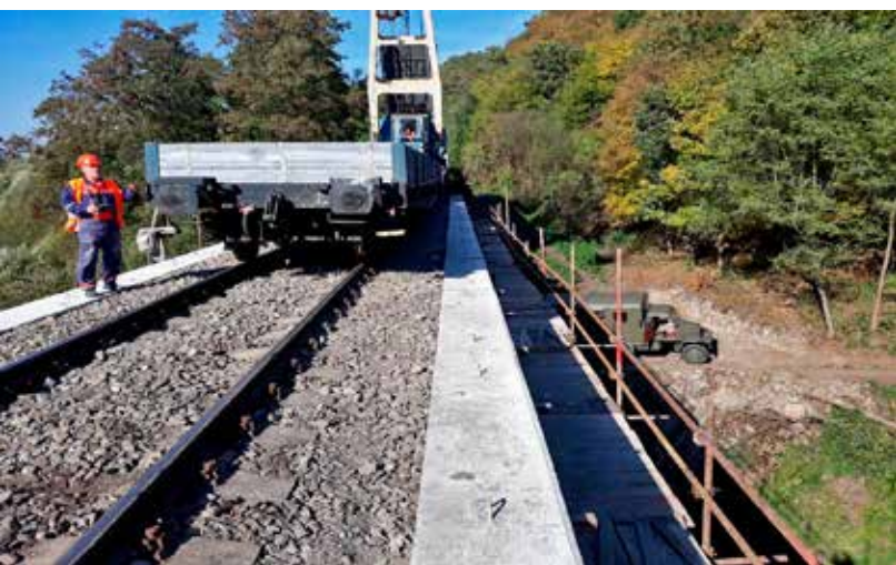
Montáž prefabrikátov na moste v nepretržitých výlukách.
