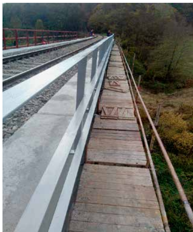
Montáž zábradlia v dĺžke cca 200 m.
