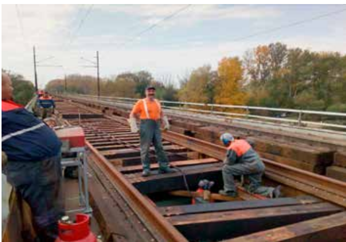
Oprava - nitovanie koľaje č. 1.
