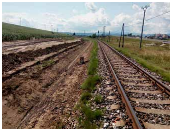
Priekopa po odstránení nánosov bahna v km 4,200 – 4,300.
