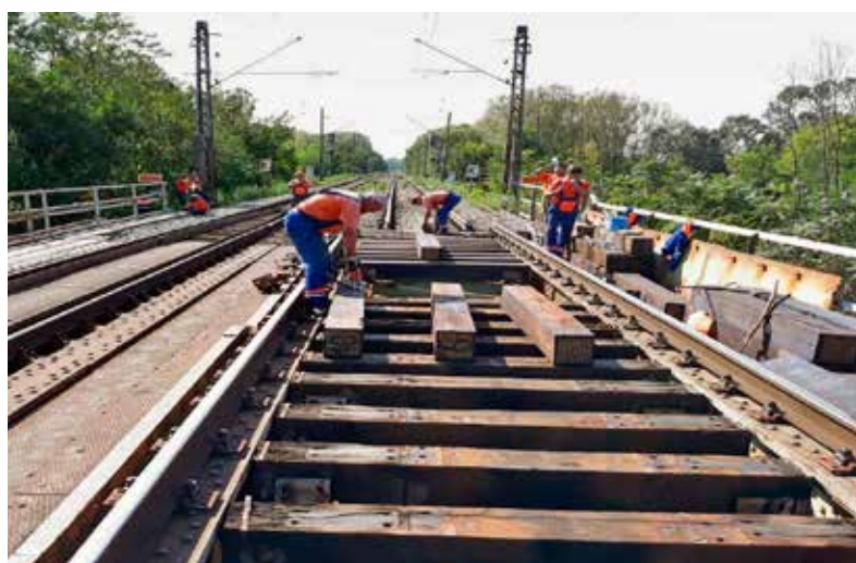
Výmena starých mostníc za nové pri centrickom upevnení koľaje č. 2.
