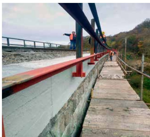
Montáž a náter zábradlia.
