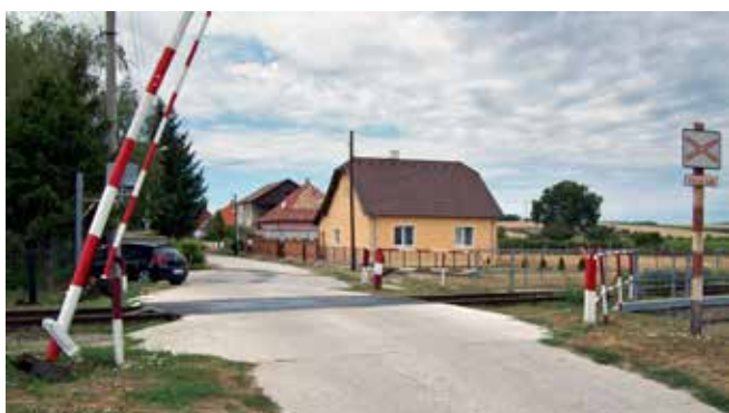
Pôvodný stav priecestia v Hrušovanych.
