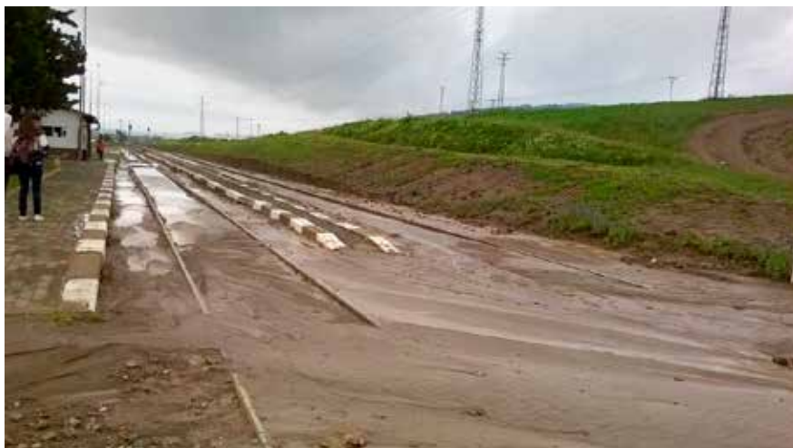
Nánosy bahna na koľaj č. 1, 2 v ŽST Matejovce pri Poprade po prílivových dažďoch z 24. mája 2018.
