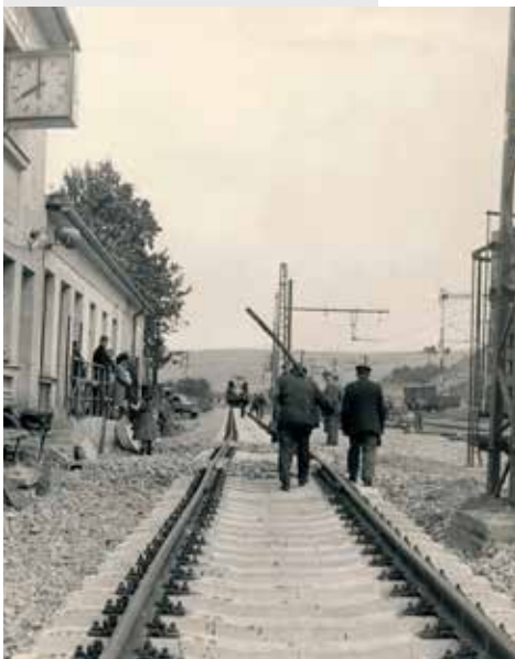
Širokorozchodná trať v stanici Ruskov počas výstavby.
