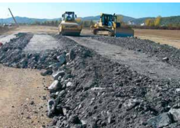
Pri budovaní budúcej úplne novej železničnej trate sa aktuálne realizuje násyp telesa železničného spodku.
