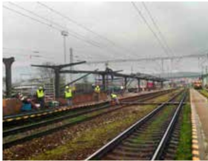
Komplexná realizácia asanácie 2. nástupišťa.
