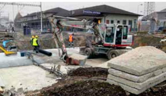
Dokončovanie práce na podchode pre cestujúcich, pokladanie izolácie a zaspávanie.
