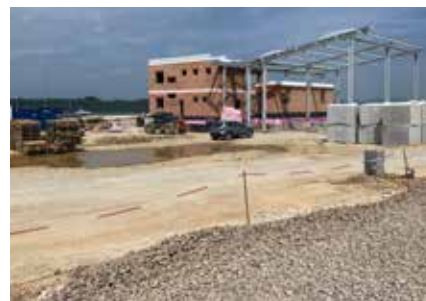
Výstavba výpravnej budovy Lužianky TIP.
