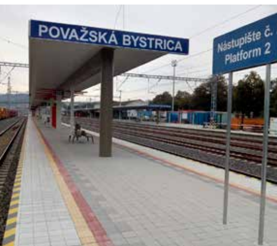
Novovybudované 2. nástupište v dĺžke 400 metrov s novým mobiliárom a informačnými tabuľkami a dokončená kompletná modernizácia staničných koľají na párnej strane.
