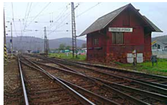
Bývalé stavadlo 1 na žilinskom zhlaví, ktoré bolo zbúrané v 3. etape stavebných postupov.
