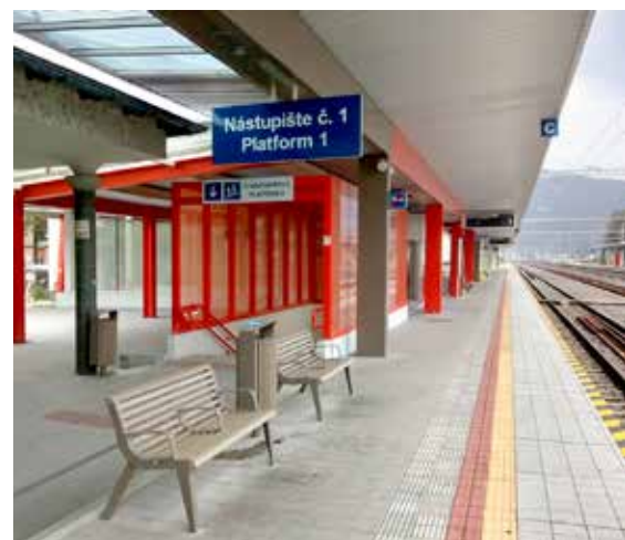
Novovybudované 1. nástupište v dĺžke 400 metrov s novým mobiliárom a informačnými tabuľkami.
