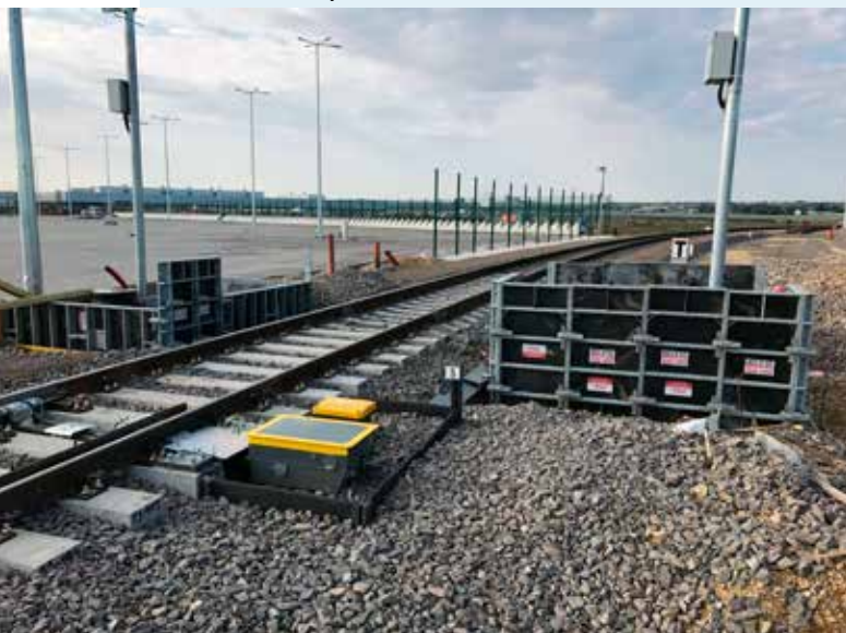
Betonáž základov pre železničnú bránu.
