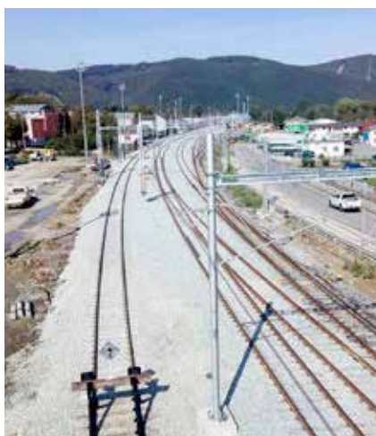
Zmodernizované žilinské zhlavie, prvá a druhá staničná koľaj, trolejové vedenie, osvetlenie, výhybky.
