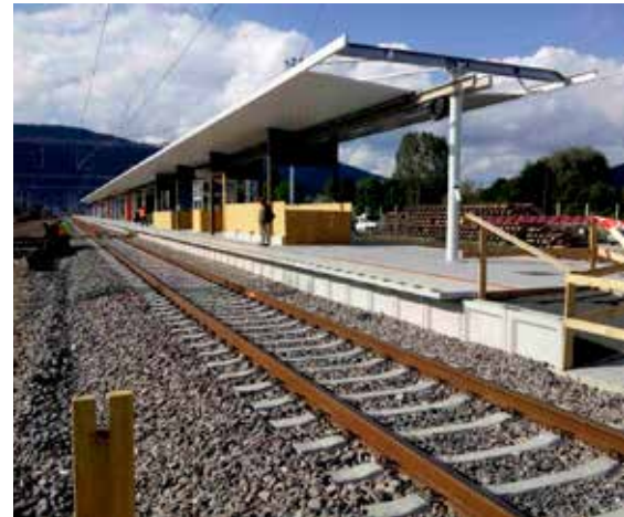
Novovybudované, ale nedokončené 2. nástupište a nová 4. staničná koľaj.
