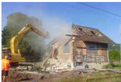
Realizácia asanácie stavadla 2. na púchovskom zhlaví.
