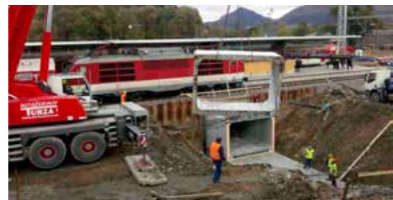
Realizácia a výkopové práce podchodu pre cestujúcich, pokladanie tvárnic.
