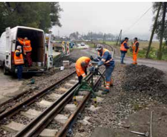
Pracovníci ŽSR pracujú na oprave priecestia.
