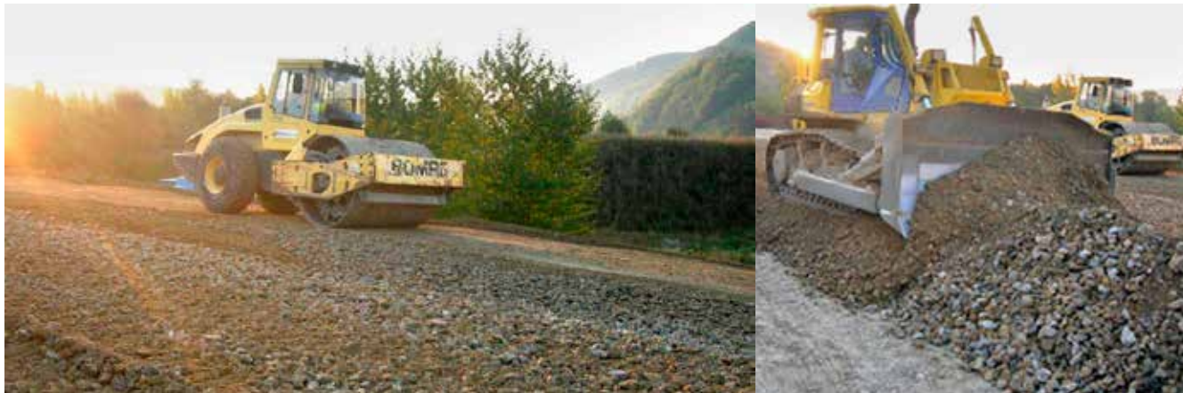
Pri budovaní budúcej úplne novej železničnej trate sa aktuálne realizuje násyp telesa železničného spodku.
