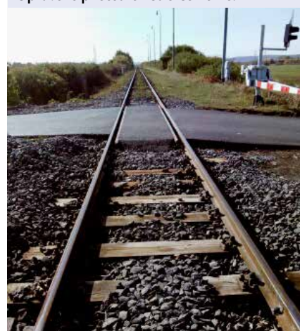
Opravené priecestie Pusté Čemerné.
