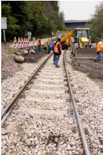
Priecestie v úseku Medzibrodie nad Oravou – Dolný Kubín pred rekonštrukciou.
