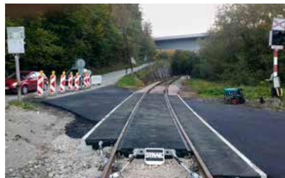
Opravené priecestie po rekonštrukcii.
