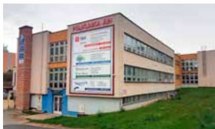
Pohľad na budovu polikliniky JUH Trenčín z hlavnej cesty.
