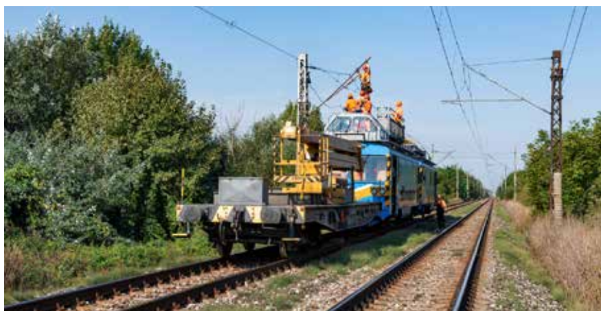
Elektromontéri OR Trnava pracovali nepretržite na oprave poškodeného trakčného vedenia.
