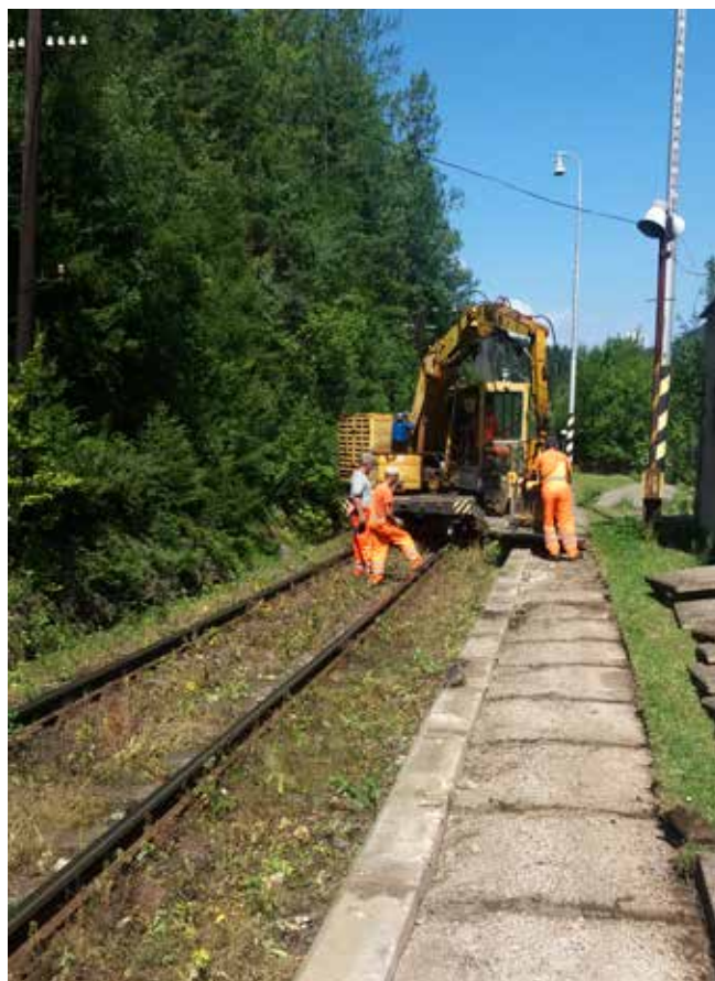
Pred čistením koľajového lôžka bolo potrebné upraviť aj nástupište.
