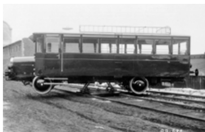
Lahký motorový vozeň radu M 120.1 z roku 1927 počas otáčania na vlastnej točnici.
