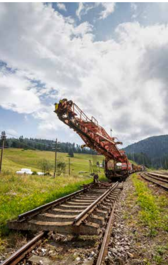
Dočasne odstránené koľajové pole v ŽST Dobšiná.
