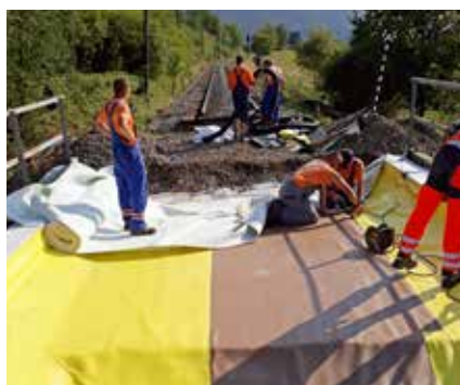
Zváranie hydroizolačnej fólie.
