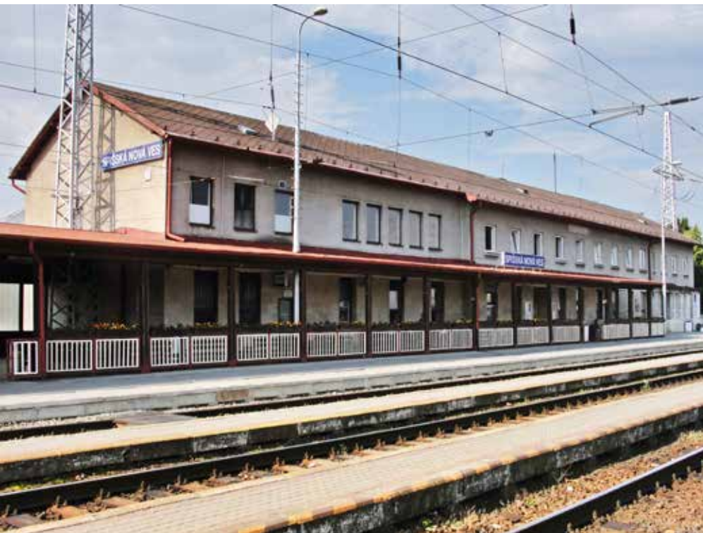
Zrekonštruovaná stanica bude pre cestujúcich, ale aj pre zamestnancov komfortnejšia.
