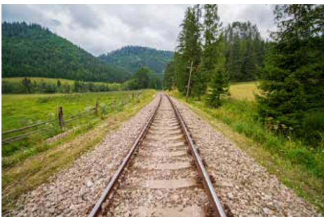
Finálny pohľad na trať v úseku ŽST Dobšinská Ľadová Jaskyňa – ŽST Telgárt.
