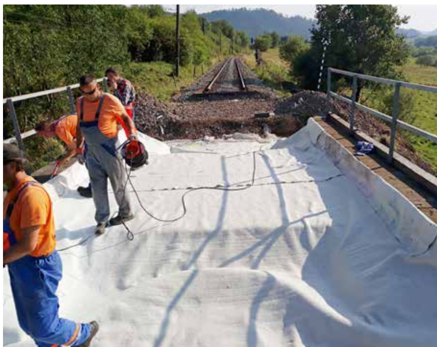
Nanesenie vrchnej ochranej vrstvy geotextílie a vytmelenie škár proti zatekaniu vody.
