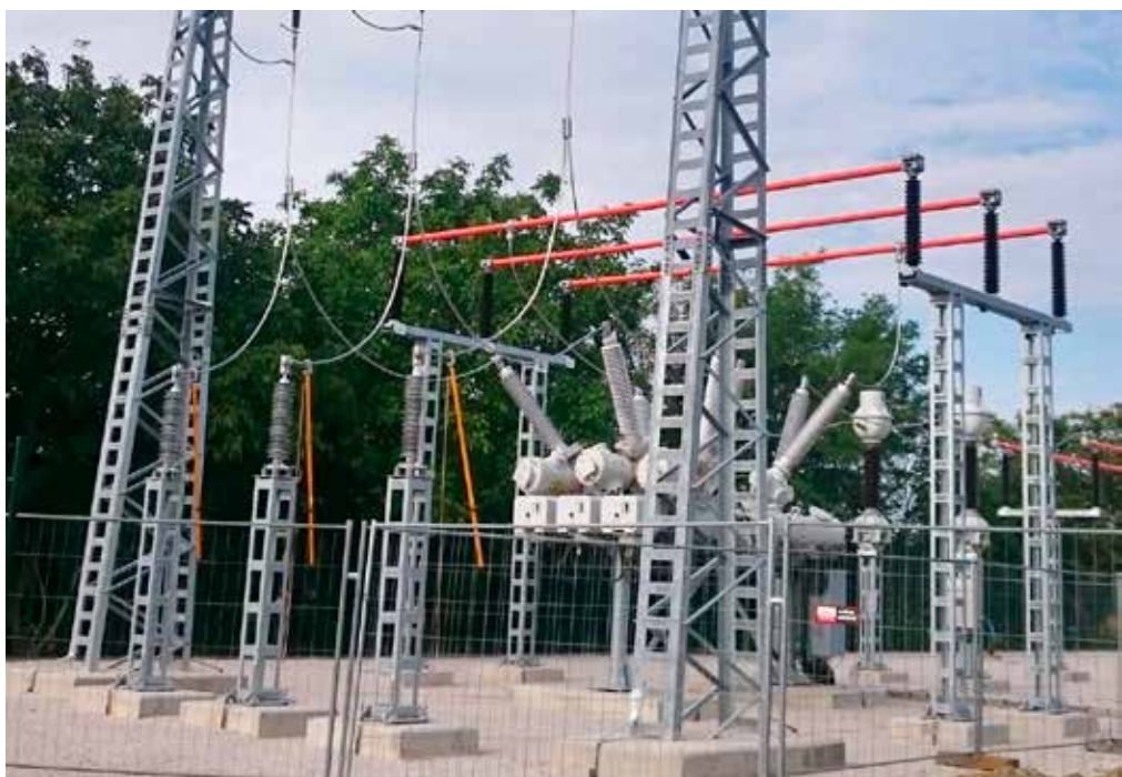
Namontované zariadenie PASS rozvodne 110 kV v TNS Galanta pred zavedením do skúšobnej prevádzky.
