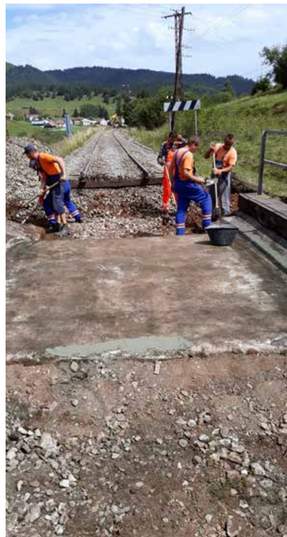
Očistenie železobetónovej dosky mosta pred nanosením hydroizolácie a príprava na oddrenávanie opôr.
