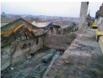
Bezprostredne po obrovskom požiari začali práce na provizórnom prestrešení strechy.
