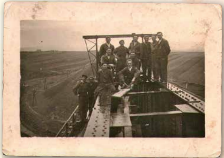
Pracovná skupina na železnej konštrukcii mosta, miesto neznáme.
