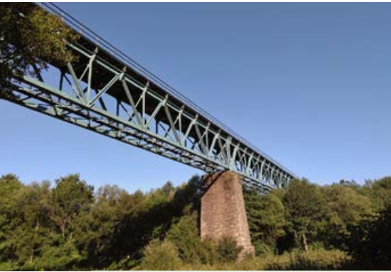
Pohľad na Devanský viadukt, na ktorom vplyvom výluky 15 dní nejazdili vlaky.
