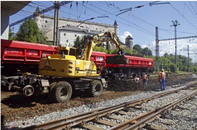
Po vytrhnutí výhybiek nasledovalo odstraňovanie starého znečisteného štrkového lôžka.
