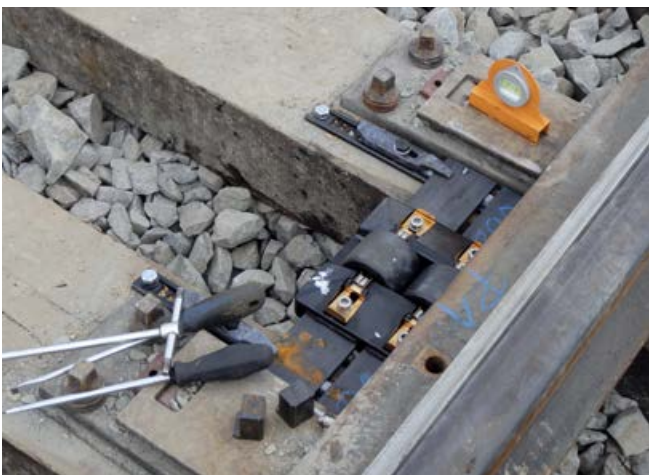
Pre správny a ľahký chod výmenovej časti výhybky boli namontované valčekové zariadenia.
