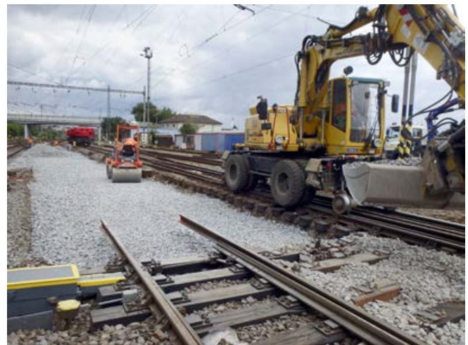
Zriaďovanie (predštrkovanie) nového štrkového lôžka so zhtutnením.
