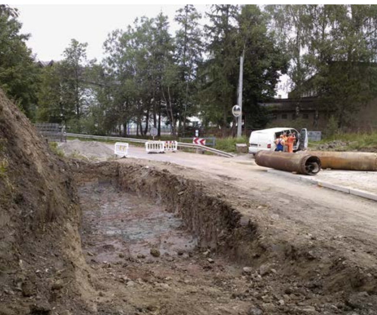
Súčasťou je aj vykopanie jamy pre mostnú oporu č.1...
