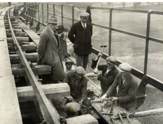
Stavba mosta na trati Nové Mesto nad Váhom - Veselí nad Moravou.
