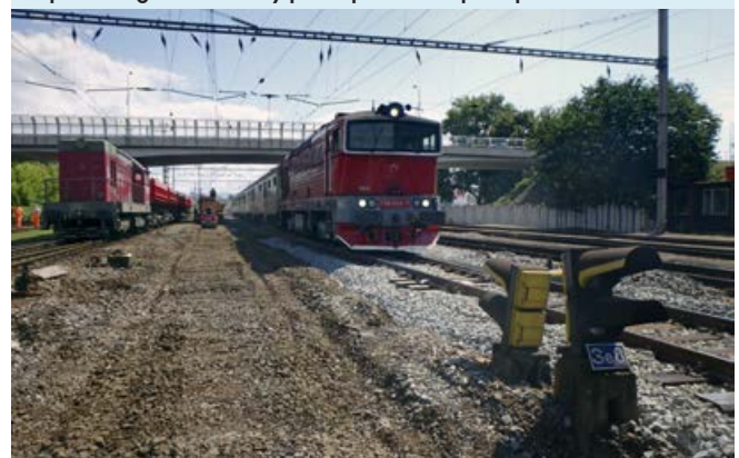
Pred spustením prevádzky bolo potrebné výhybky dať do správnej výškovej a smerovej polohy.
