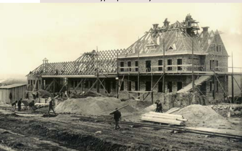
Železničná stanica Myjava počas stavby.
