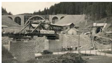
Výstavba partie pri zastávke Telgárt penzión.
