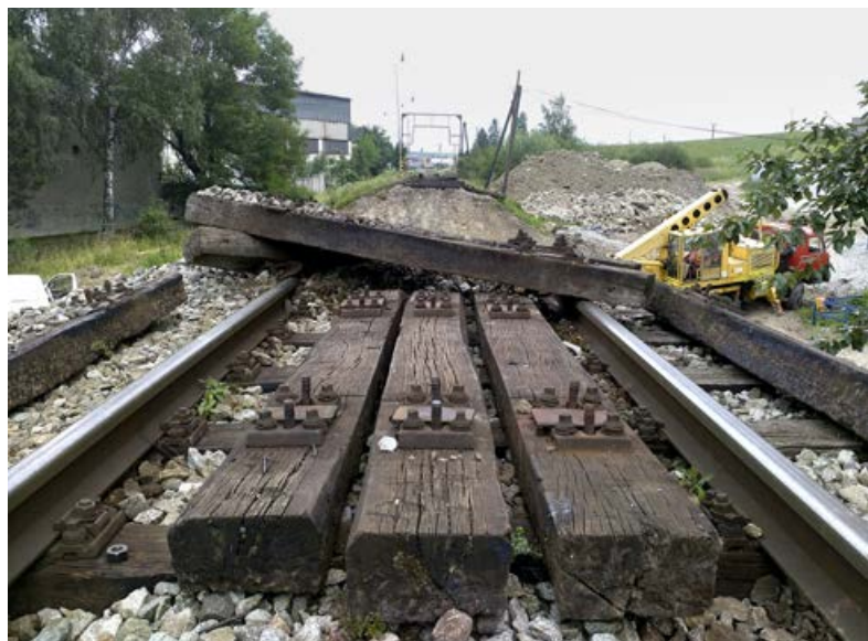
Rekonštrukcia mostu na trati Kral'ovany – Trstená v km 56,204 začala 2. júla.
