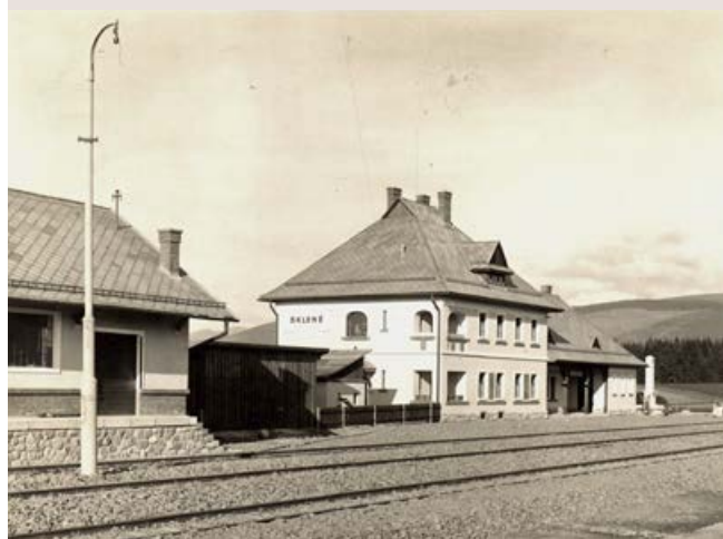
Stanica Sklené medzi Handlovou a Hornou Štubňou.
