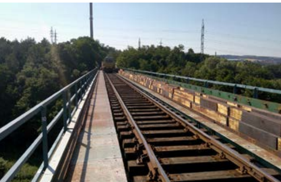
Rekonštrukcia sa začala 20. júna.
