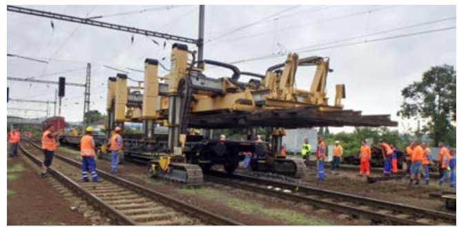
Výluka sa začala trhaním starých výhybiek strojom DESEC.
