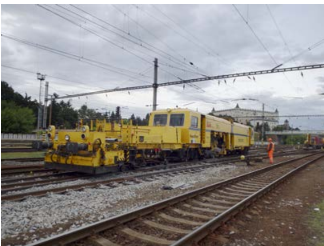
Pred spustením prevádzky bolo potrebné výhybky dať do správnej výškovej a smerovej polohy.
