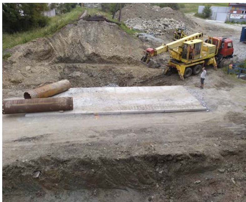
...a pokládka betónových panelov.
