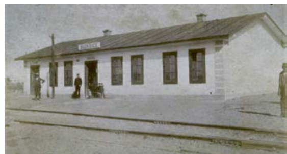
Stanica Budkovce na trati Bánovce nad Ondavou - Vajany.
