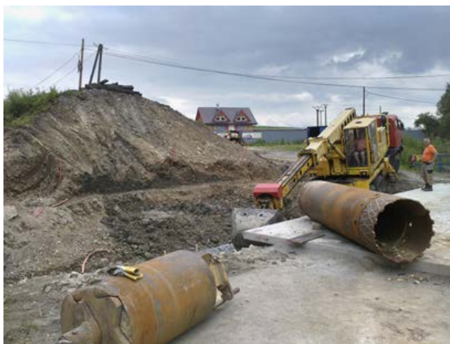
Výkopové práce na mostnú oporu č. 2.
