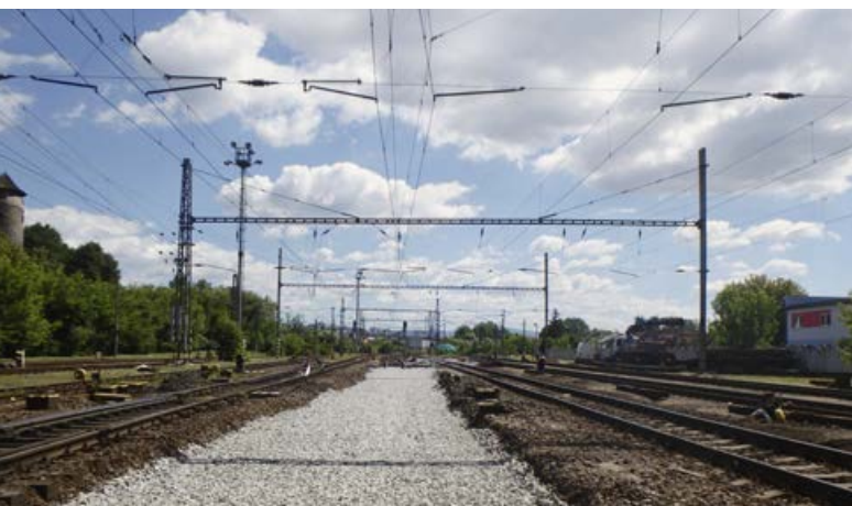
Všetko je pripravené na pokládku nových výhybiek.
