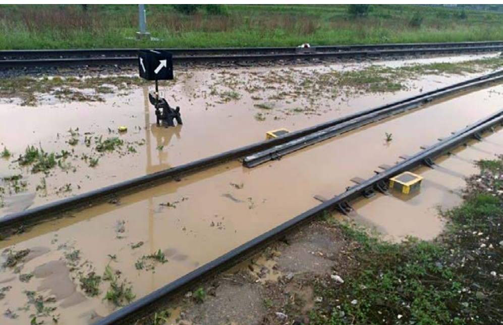
Zaplavené koľaje spôsobili prerušenie železničnej dopravy na niekoľko hodín.
