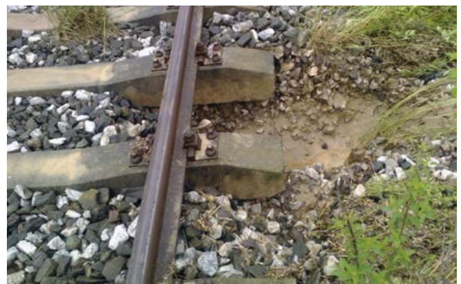
Búrky a dažde pokračovali aj v júni, 14.6. v úseku Spišské Vlaky – Spišské Podhradie došlo k podmytiu trate a na takmer 4 hodiny bola železničná doprava prerušená.
