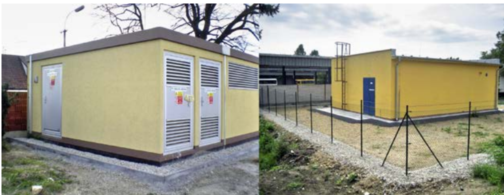
Transformačné stanice murované, blokové či kioskové.
