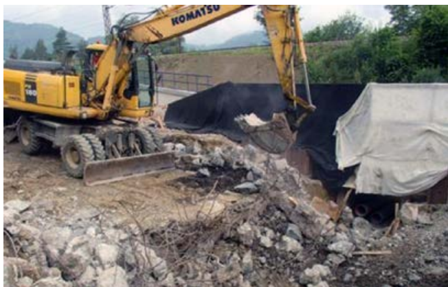
Budovanie oporného múru
