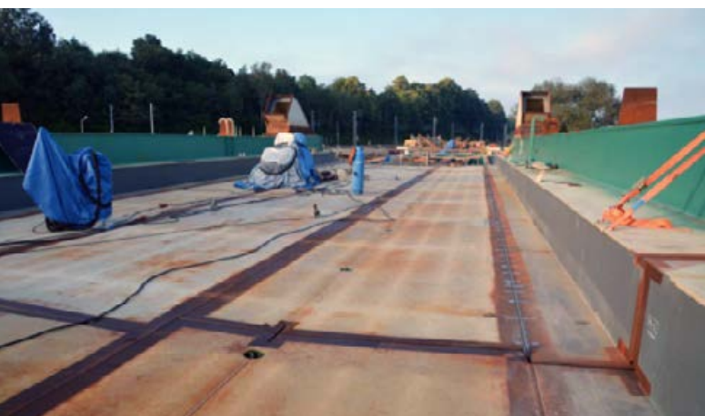
Nový železničný most nad nosickým kanálom
