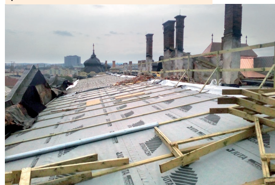
Po požiaru musela byť vyprataná suť a zhorený materiál zo všetkých priestorov – strechy, podkrovia, nádvoria budovy, chodníka pri južnej fasáde. Dnes už má časť strechy, zasiahnutá požiarom, nové zastrešenie.
