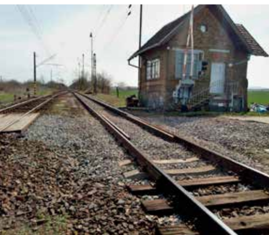
V stanici Strekov železničari opravili aj priecestie.
