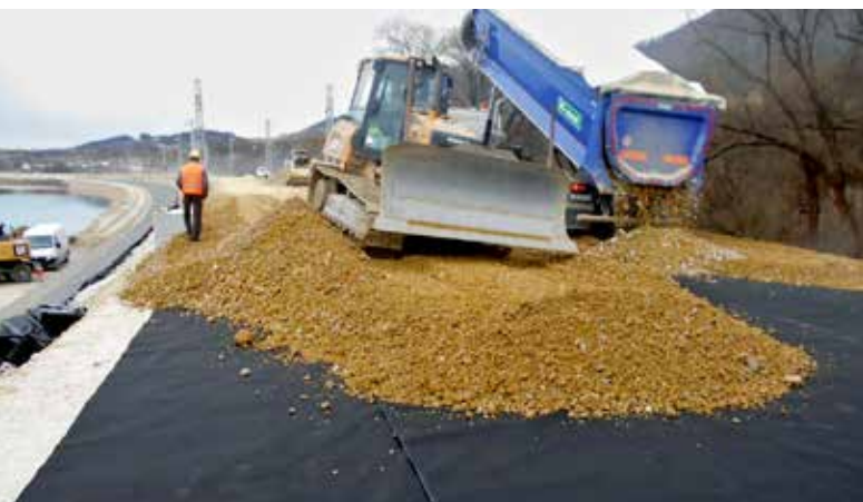
Sypanie sanačnej vrstvy a hutnenie, svahovanie násypu a pokládka geotextílie sú súčasťou prác na novom železničnom spodku.
