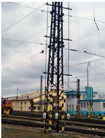
Úsekové odpínače s ručne ovládaným pohonom...
