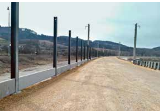
Osadzovanie prvej rady soklových panelov má za sebou budúca protihluková stena.
