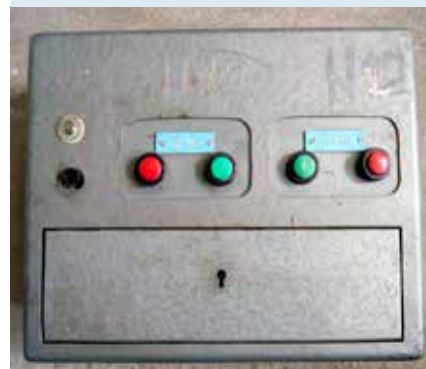
... a úsekové odpínače motorové, ktoré sú ovládané z dopravnej kancelárie cez pult.
