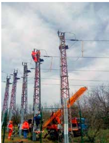
Práce na výmene úsekových odpínačov.
