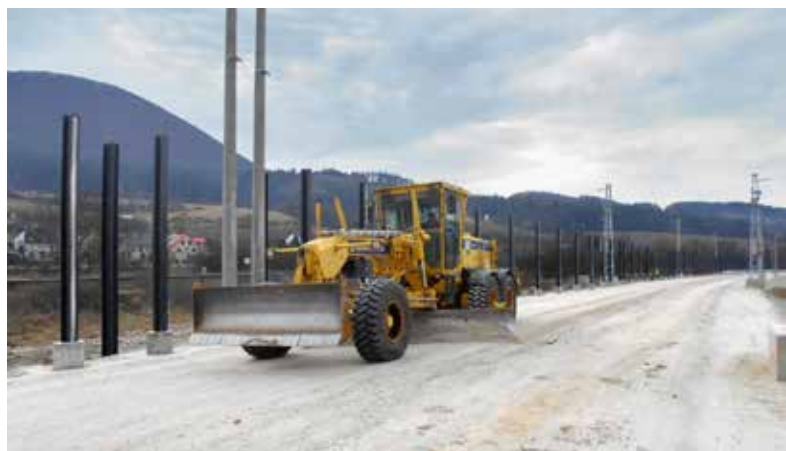
Sypanie sanačnej vrstvy a hutnenie, svahovanie násypu a pokládka geotextílie sú súčasťou prác na novom železničnom spodku.
