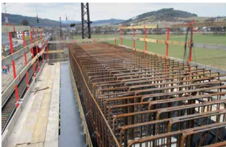
Takto prebiehajú práce na novom cestnom nadjazde, polozenie trojosej geomreže, sypanie štrkového vankúša pod základ piliera P2, armovanie a debnenie na podkladový betón pod základ piliera P2.
