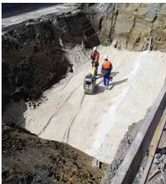
Takto prebiehajú práce na novom cestnom nadjazde, polozenie trojosej geomreže, sypanie štrkového vankúša pod základ piliera P2, armovanie a debnenie na podkladový betón pod základ piliera P2.
