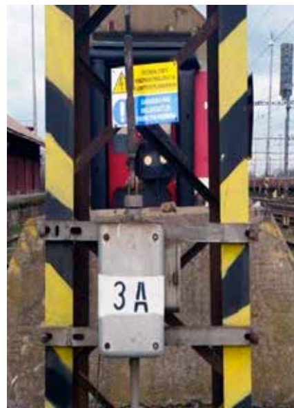
... a úsekové odpínače motorové, ktoré sú ovládané z dopravnej kancelárie cez pult.
