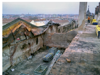
Po požiaru musela byť vyprataná suť a zhorený materiál zo všetkých priestorov – strechy, podkrovia, nádvoria budovy, chodníka pri južnej fasáde. Dnes už má časť strechy, zasiahnutá požiarom, nové zastrešenie.
