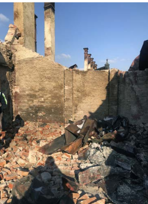
Časť strechy budovy požiar úplne zničil, prvoradé bolo čo najskôr zabezpečiť provízorne prekrytie.
