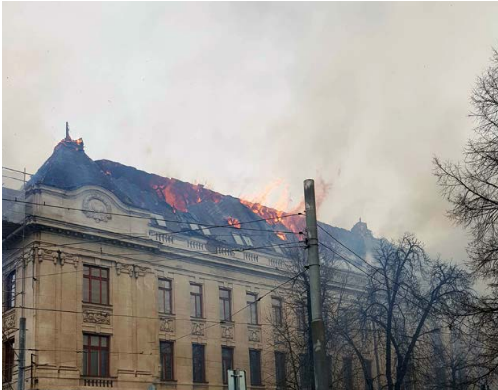
Strechu historickej budovy na Hviezdoslavovej ulici v Košiciach zasialhol koncom februára rozsiahly požiar.
