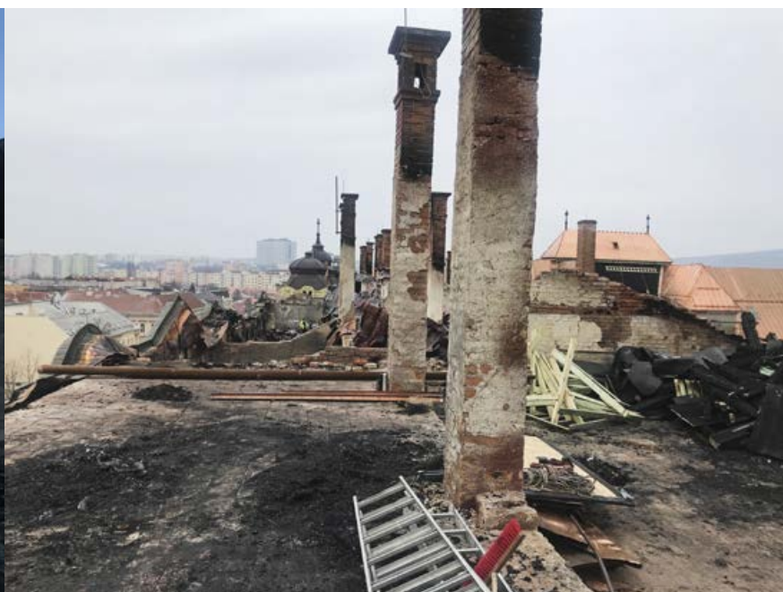
Časť strechy budovy požiar úplne zničil, prvoradé bolo čo najskôr zabezpečiť provízorne prekrytie.
