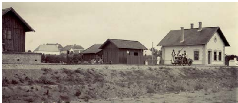
Stanica Ozorovce na trati Trenčín - Chynorany počas výstavby.
