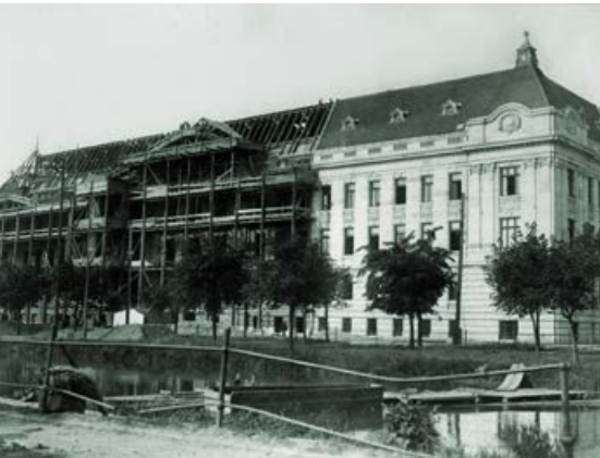
Takto vyzerala budova na Železničnej 1 pred približne 100 rokmi.
