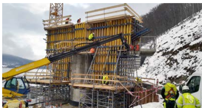
Montáž debnenia piliera P2.
