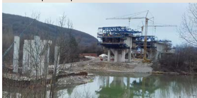
Stavebný objekt 44.33.11, nový železničný most nad riekou Váh Pohľad na realizáciu vodorovnej nosnej konštrukcie vahadlá pomocou vozíkov letmej betonáže pilierov P2 a P3.
