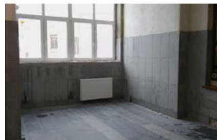
Namontovali sa nové radiátory.
