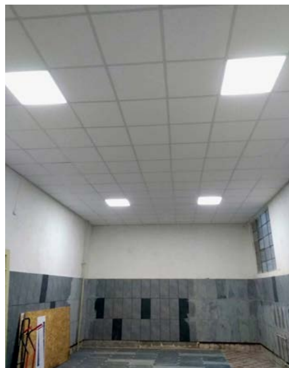
Pribudlo aj nové osvetlenie v znížennom kazezovom strope.
