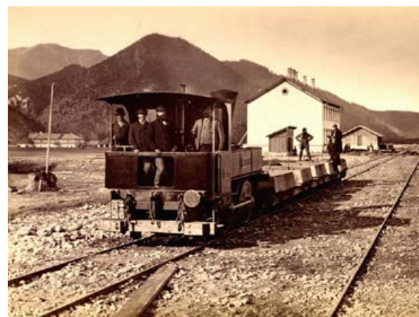
Železničná stanica Liptovský Hrádok na Košicko-bohumínskej železnici počas výstavby.
