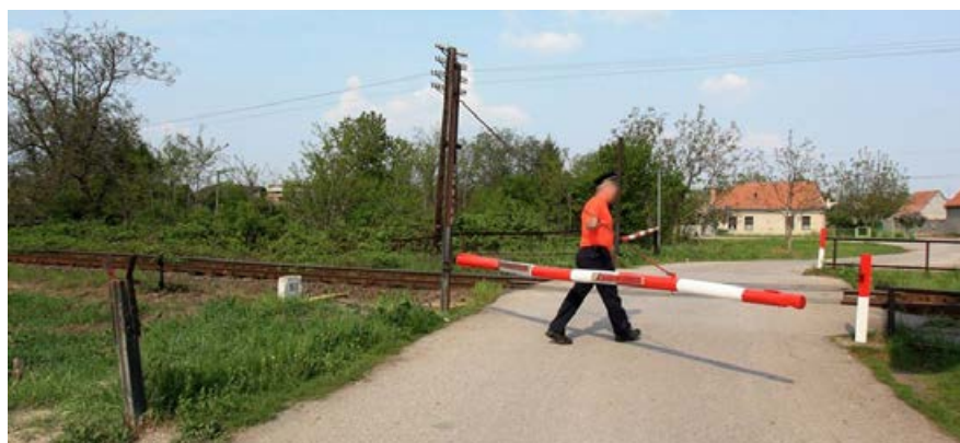
Pohľad, aký sa vám nenaskytne nikde inde na Slovensku – závorár ručne „zatvára“ závory, ktoré sú bez kľukového pohonu.
