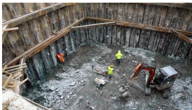
Stavebný objekt 44.33.11, nový železničný most nad Nosickým kanálom Prevádzkanie výkopu stavebnej jamy do tretej úrovne rozperného systému piliera P3.
