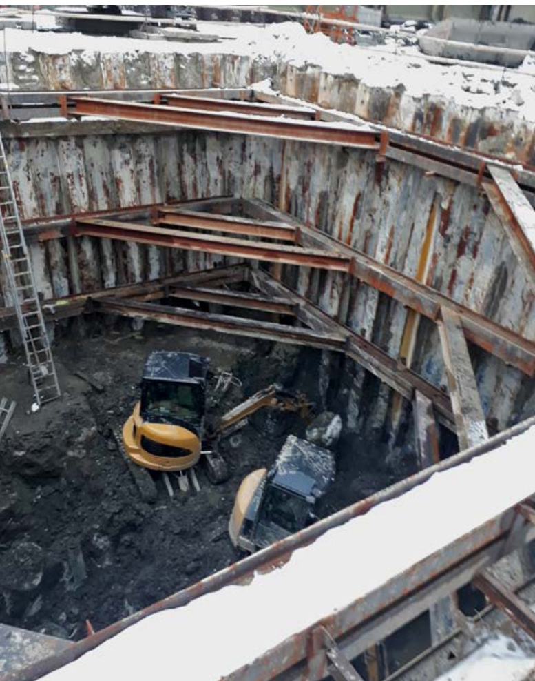
Odkop na podkladný betón v stavebnej jamě P6.
