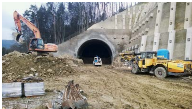
Stavebný objekt 44.33.35, tunel Milochovej Razenie tunela Milochovej v kalote a osadenie kari sieť primárneho ostenia; striekanie primárneho ostenia a čelby. Vyrazené k 7. 2. 2018: 22,5 m.
