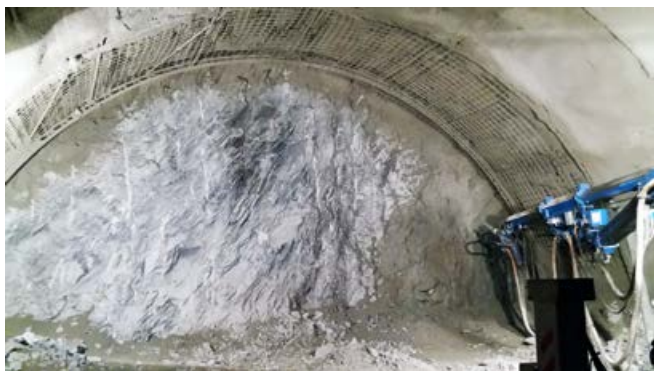
Stavebný objekt 44.33.30, tunel Diel: Razenie tunela Diel v kalote a osadenie kari sieť primárneho ostenia; striekanie primárneho ostenia a čelby. Vyrazené k 7. 2. 2018: 341,13 m.
