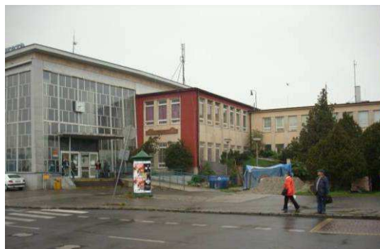
Budova ŽST – pravé krídlo
