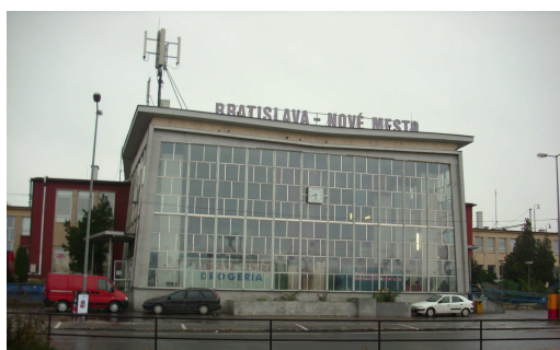
Budova ŽST – čelný pohľad
